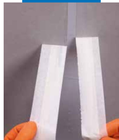
Bruk maskeringstape for å unngå sol. Må fjernes før Mapeflex PU40 har herdet
