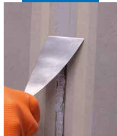
Glattning av Mapeflex PU40
