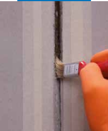
Påføring av Primer
