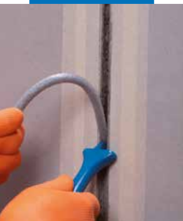
Montering av bunnfyllingslist
