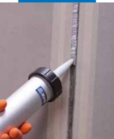
Påføring av Mapeflex PU40
